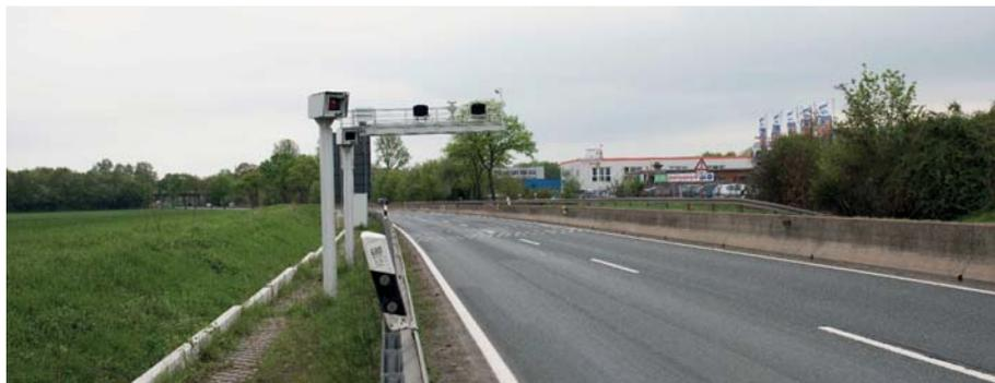
Rückwärtige Sicht auf den Beginn der Messstrecke mit Spurkamera und Kennzeichen-Scanner
