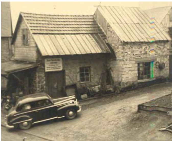
In dieser Werkstatt in Hirschberg war die Firma Dietrich Waagenbau in den Jahren nach dem Zweiten Weltkrieg untergebracht.
