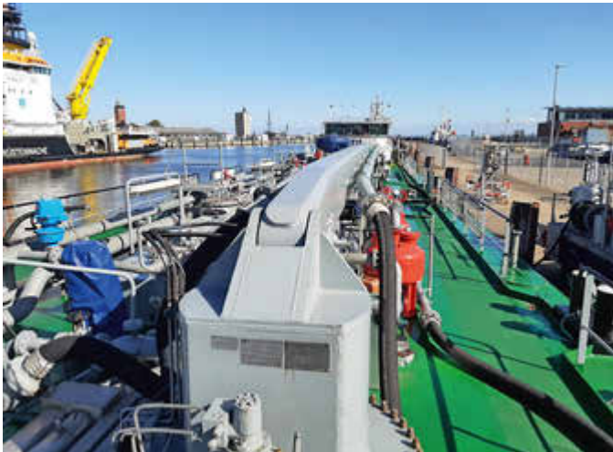
Blick vom Bug des Bunkerbootes zum Heck. Mittig ist der Ladebaum mit Zuführungsschlauch und Leitung zum Kopf des Ladebaumes zu sehen.
