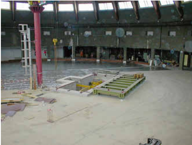
Einbau eines 30t-Massekomperators in der Lentzeallee
