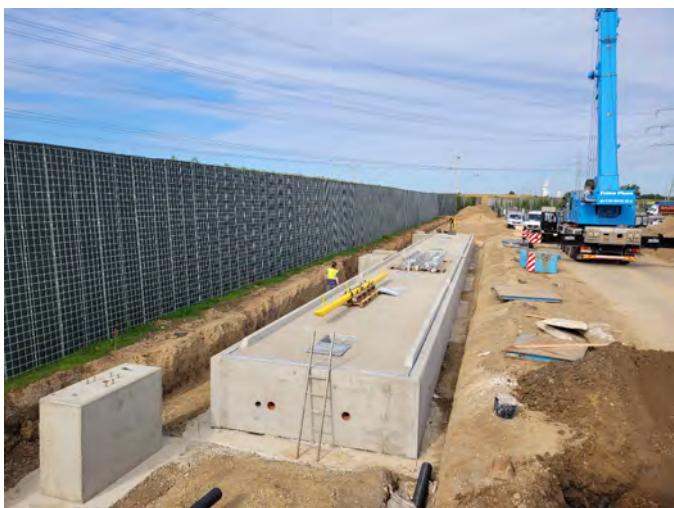
Aufbau der Lkw-Waage durch die Firma Waagenbau Dohmen GmbH
